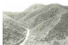
施工後2年目(S32)
