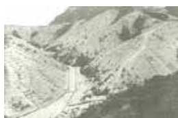
復旧工事完了(S30)
