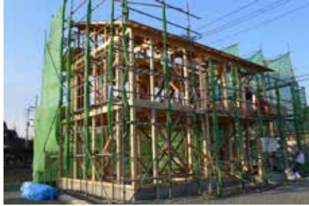
▲県産材を使用した木造住宅
