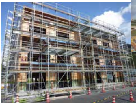
真庭市で建設が進む3階建て共同住宅
