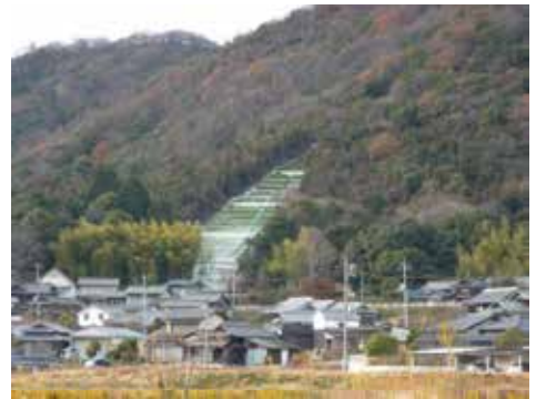
▲山地災害の復旧状況
