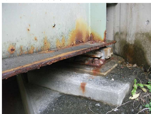
鋼桁の腐食
