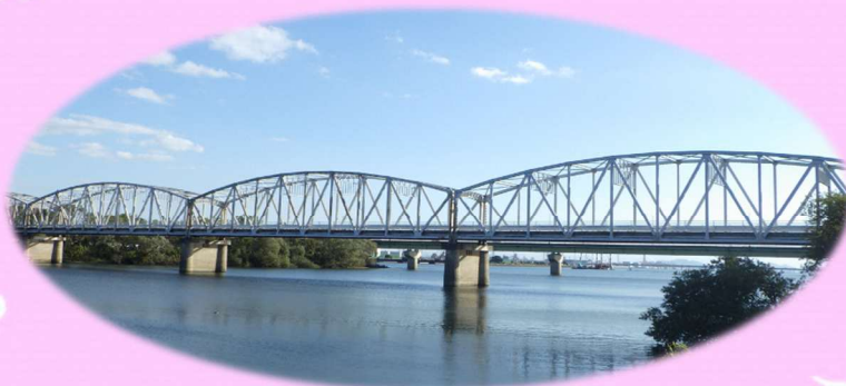
霞橋側道橋（国道429号）
