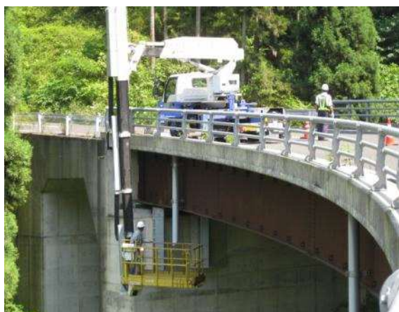
橋梁点検車による点検状況
