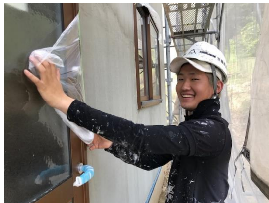
(写真:新築住宅塗装作業中の藤本さん)
