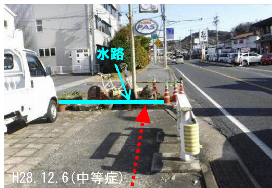
○歩道がなくなる箇所
