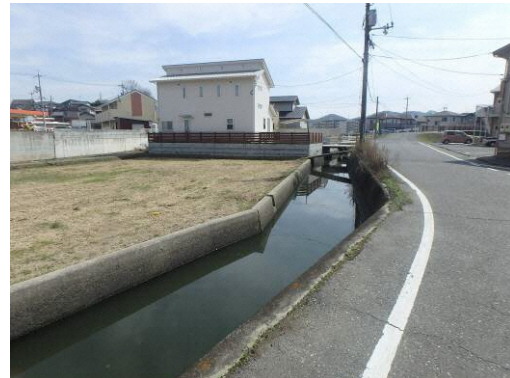
新興住宅地内道路 屈曲部の水路
