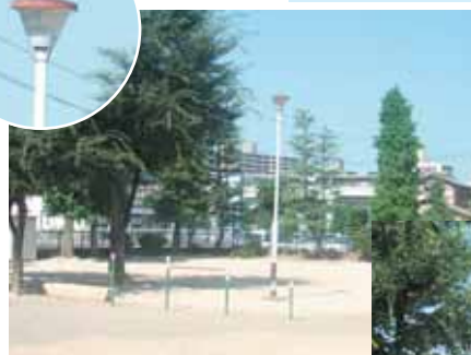
公園灯の設置
