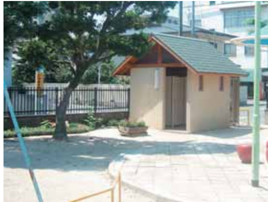
周辺から見通しが確保された位置に設置された便所
