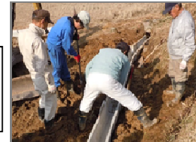
老朽化した水路の更新
