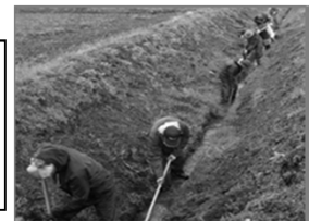
水路の泥上げ
