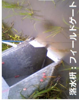
流出を抑制する落水量調整装置の例
