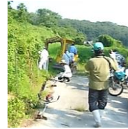
重機を使用した水路補修
