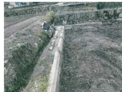
畦畔や進入路のコンクリート
