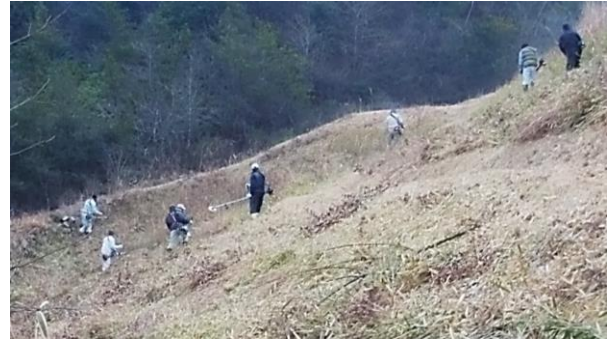
ため池堤体法面の草刈り
