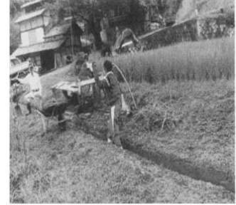
共同の水路泥上げ作業
