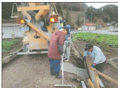
うしお 潮環境保全会 (新見市) 農道のコンクリート舗装
