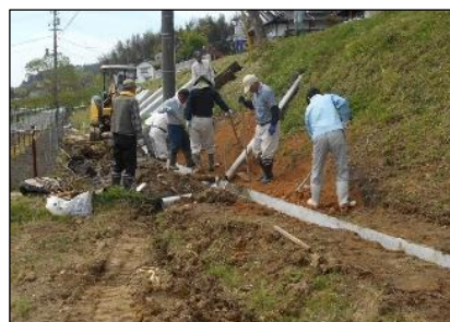
田中組織 (吉備中央町) 水路の更新
