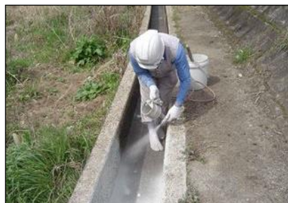
ふくいたのくま 福井・田熊地域環境保全組合 (津山市) 老朽化した水路の補修
