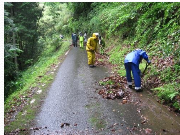
水路の泥上げ作業
