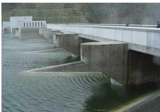
苫田ダム 越流状況
