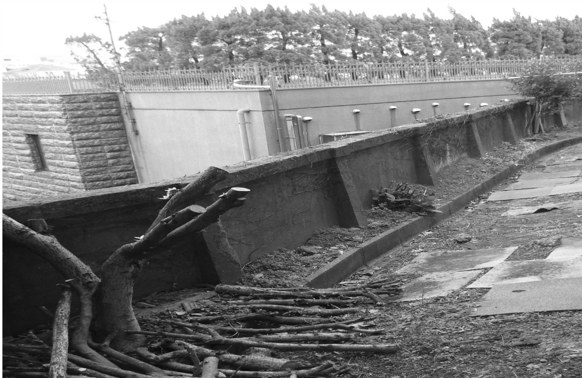
寮裏側の擁壁
