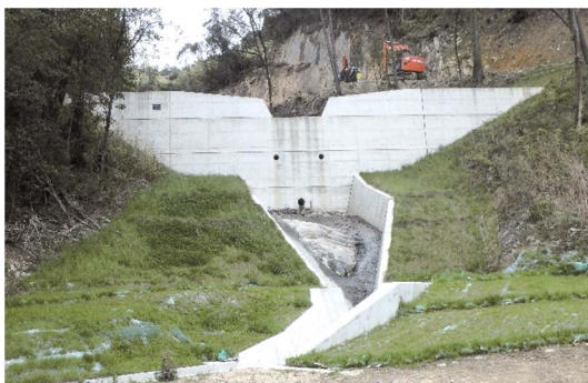
溪間工(治山ダム)による土砂流出の抑制
