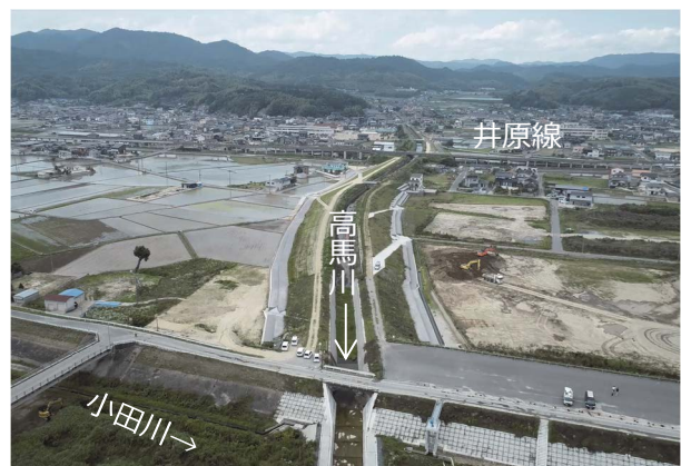
改良復旧状況（高馬川）
