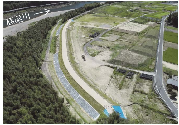
改良復旧状況（下倉地区：決壊箇所）
