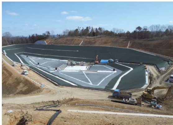
一般廃棄物最終処分場
