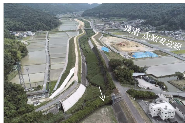
改良復旧状況（真谷川）
