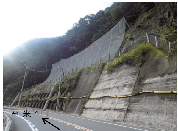
国道180号（新見市）落石防護工
