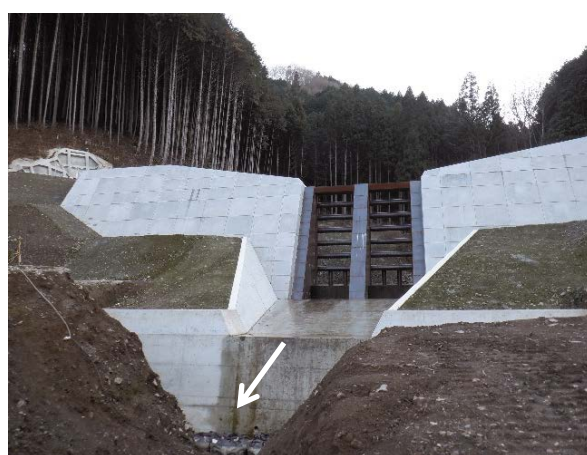
太田川 砂防堰堤 令和3年3月末完成
