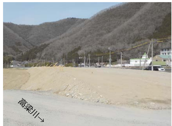
施工状況（作原地区）
