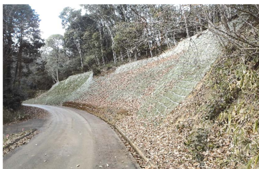
林道法面の改良による走行安全性の確保
