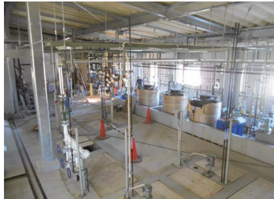
同左（浸出液処理設備）
