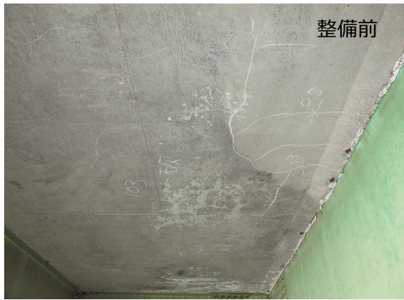
国道 429 号 霞橋 (床版補修工)
