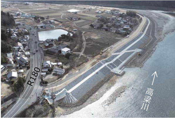
改良復旧状況（日羽地区）
