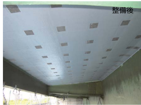
国道 429 号 霞橋 (床版補修工)
