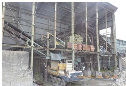
産業廃棄物処理施設（破碎施設）
