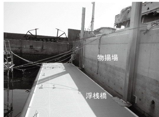
下津井漁港（物揚場・浮棧橋の更新）
