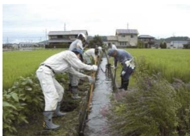
水路の泥上げ
