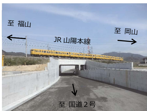
県道園井里庄線（施工状況）
