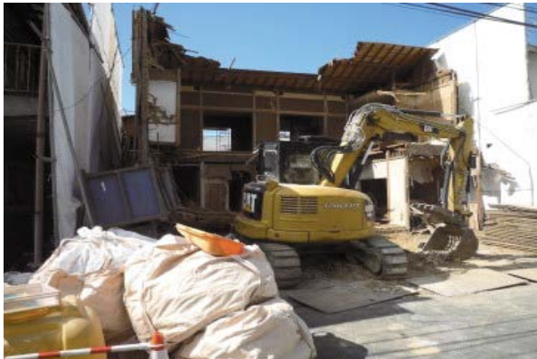
解体現場への立入検査
