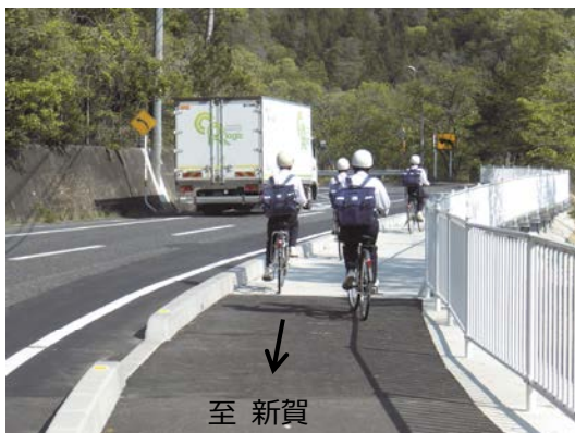
県道新賀小坂東線〈自歩道〉（笠岡市）
