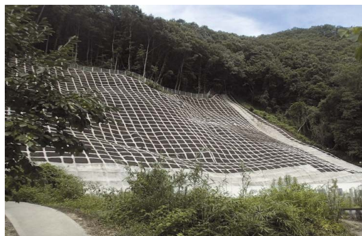
山腹工(法枠工)による山地崩壊の防止
