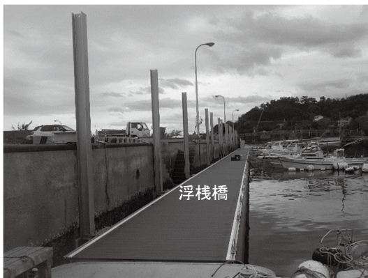
大島漁港（浮棧橋の更新）
