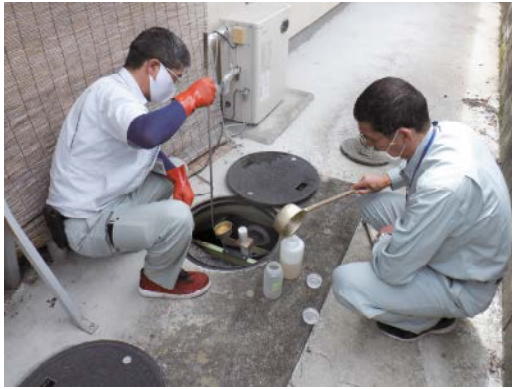
(浄化槽の使用状況の確認)
