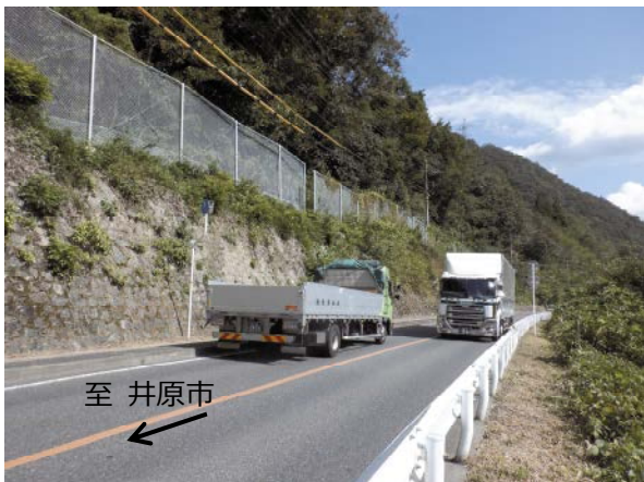
国道313号（高梁市）落石防護工
