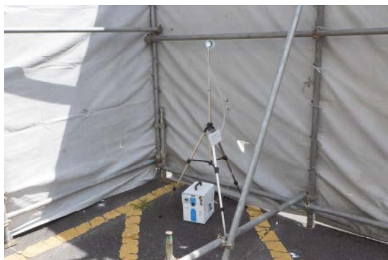
(解体工事現場でのアスベスト測定)
