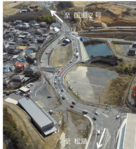
県道早島松島線（施工状況） 〔(都) 道路早島大砂線〕
