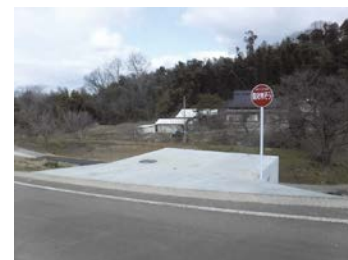
防火水槽の設置
