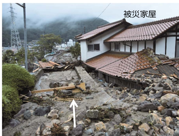
被災状況（今井谷川）
