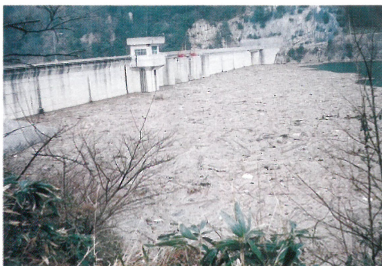
△台風10号通過後の黒木ダムの状況
