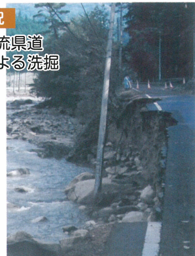
△一般県道倉見齊の谷線 加茂町黒木地内
