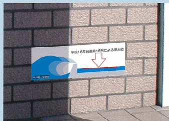
【浸水水位表示板】
