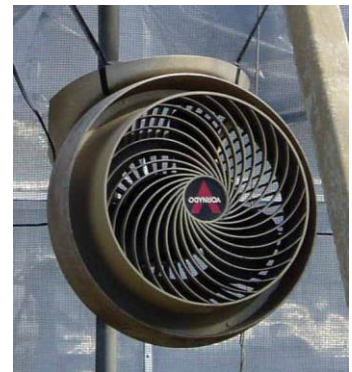
ハウス内に設置された循環扇
