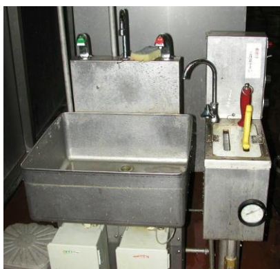
【手洗い設備とナイフ消毒装置の例】
