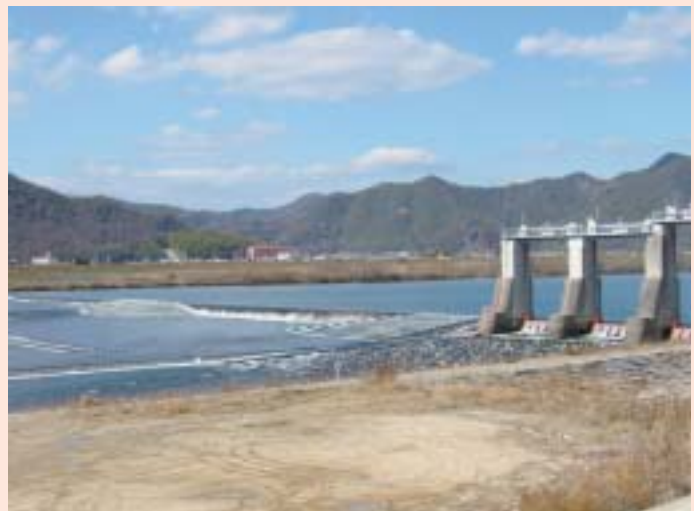
コンクリートで造った堰
