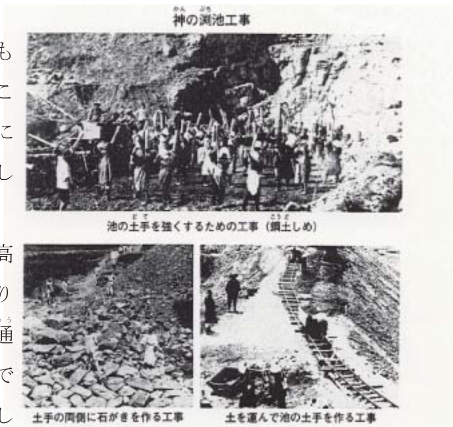
当時の工事の様子
