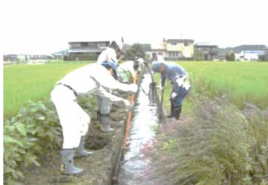
水路の泥上げ
