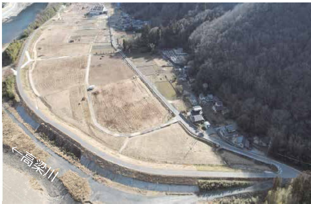
改良復旧状況（下倉地区）完成
