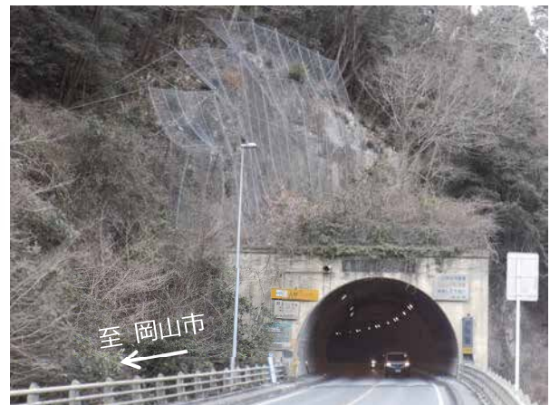
国道180号 (新見市) 落石防護工
