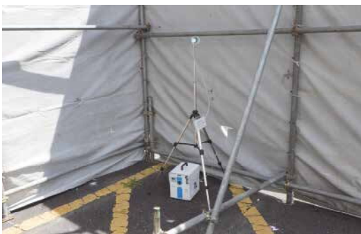
(解体工事現場でのアスベスト測定)
