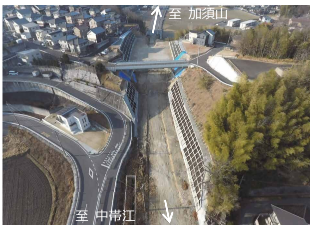
県道加須山中帯江線 （施工状況）▶
