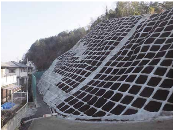
急傾斜地崩壊危険区域 中庄古向地区
