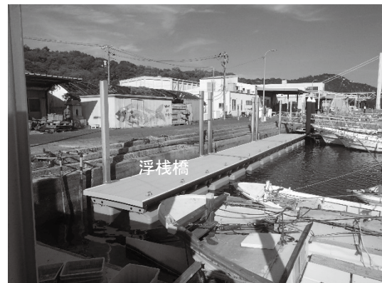
下津井漁港（浮棧橋の更新）
