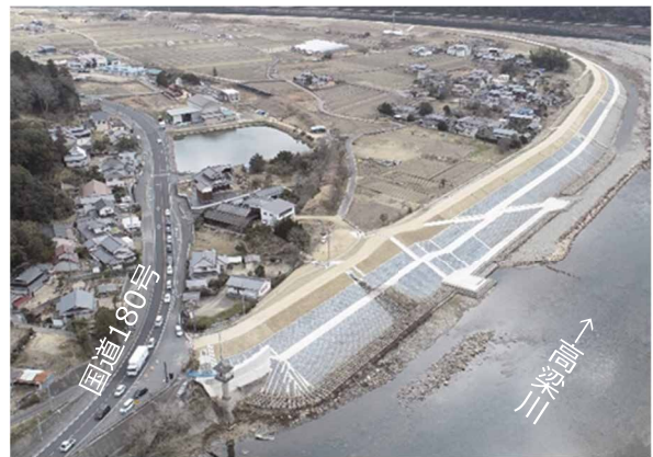
改良復旧状況（日羽地区）
