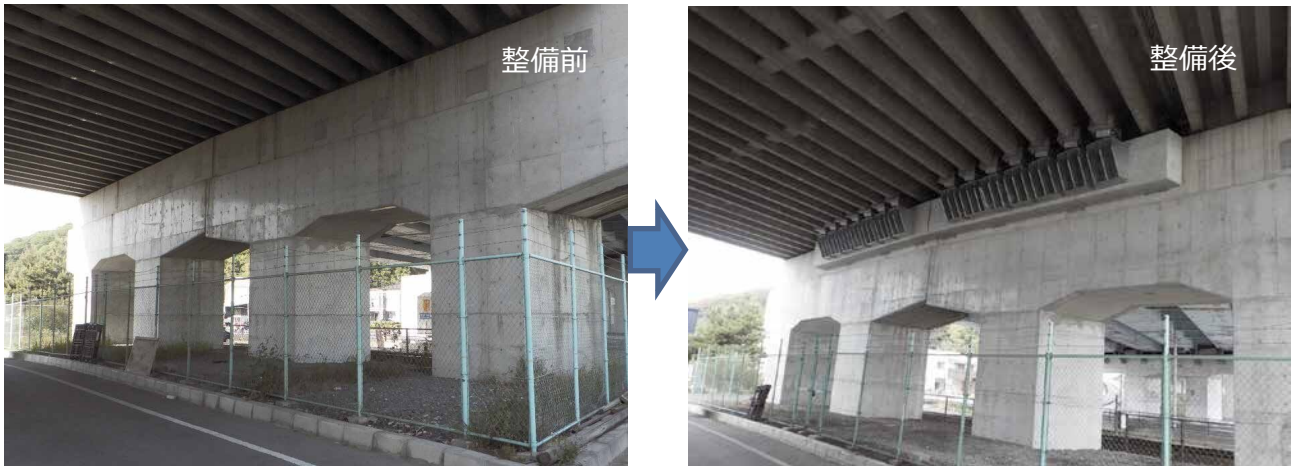
県道藤戸連島線 連島 2 号高架橋（落橋防止工）
