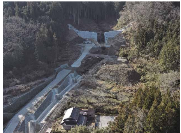
施工状況（太田川）
