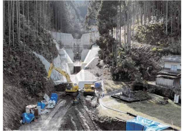
施工状況（今井谷川）
