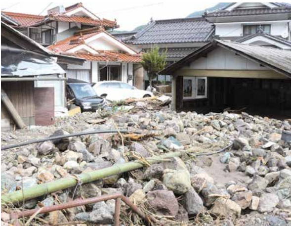
被災状況（太田川）
