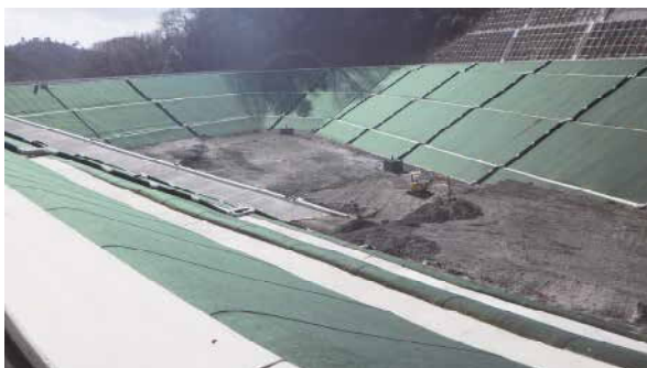
一般廃棄物最終処分場
