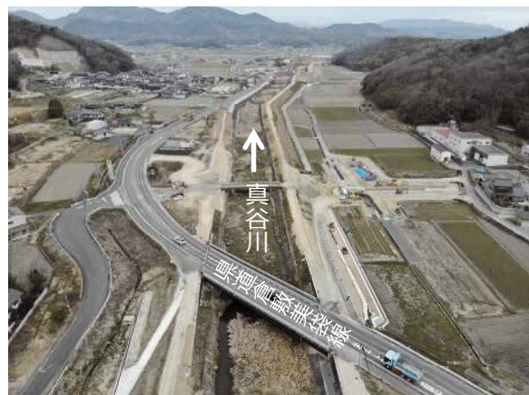
改良復旧状況 (真谷川)
