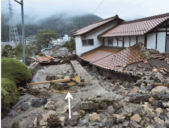
被災状況（今井谷川）
