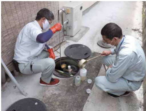
(浄化槽の使用状況の確認)
