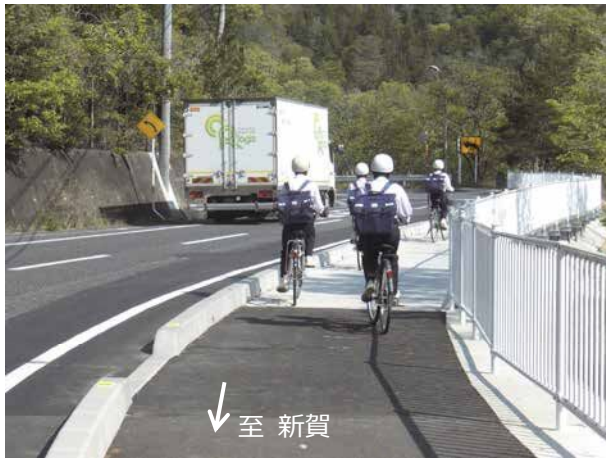
県道新賀小坂東線〈自歩道〉（笠岡市）
