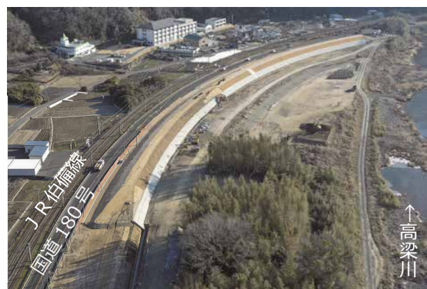
施工状況（作原地区）
