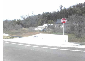
防火水槽の設置
