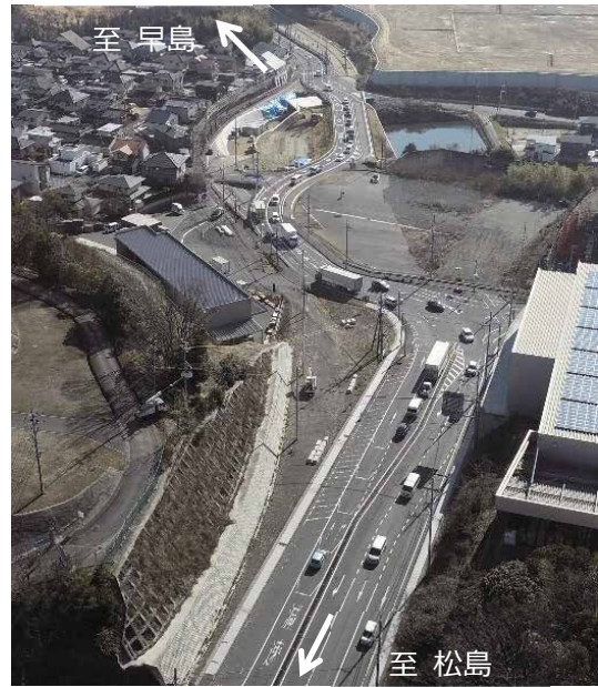
県道早島松島線（施工状況）▶
