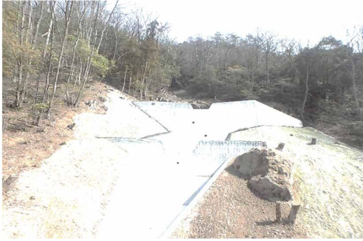
溪間工（治山ダム）による土砂流出の抑制
