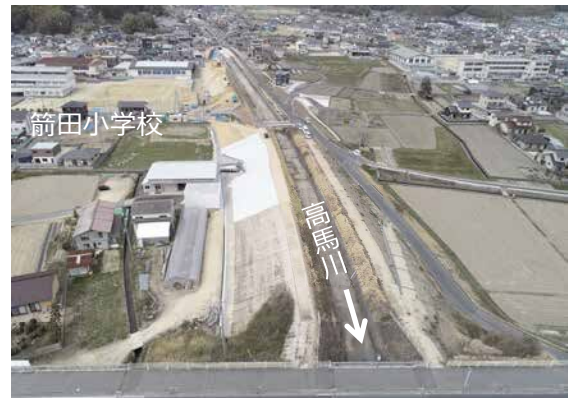
改良復旧状況 (高馬川)
