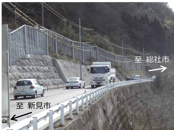
国道180号 (高梁市) 落石防護工
