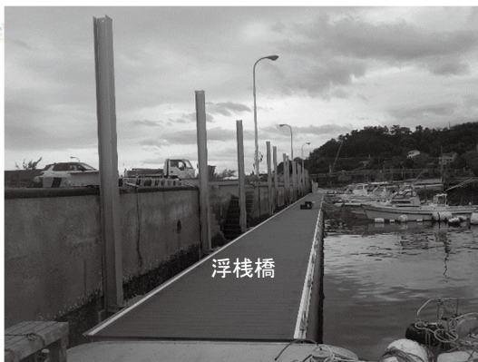
大島漁港（浮棧橋の更新）
