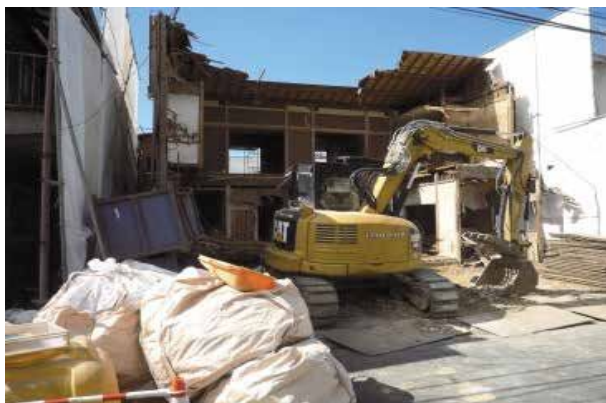
解体現場への立入検査
