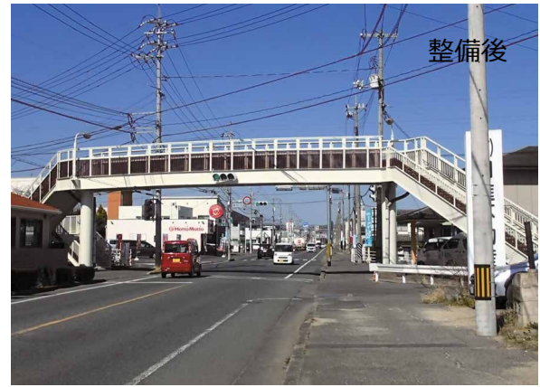
県道水島港線（倉敷市）（江長歩道橋・再塗装工）
