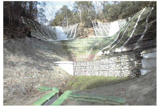
山腹工（法枠工）による山腹崩壊の防止
