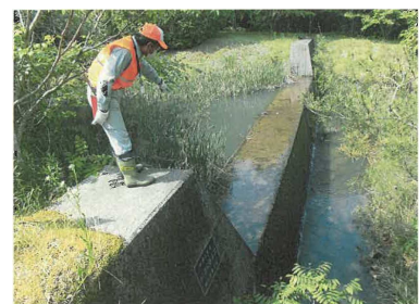
治山施設の点検
