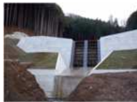
砂防施設整備
