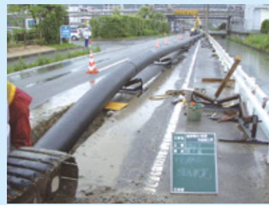
老朽管の更新 (耐震性、耐腐食性の高い管に更新)
