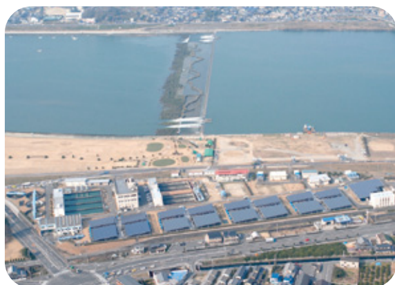
西之浦浄水場
