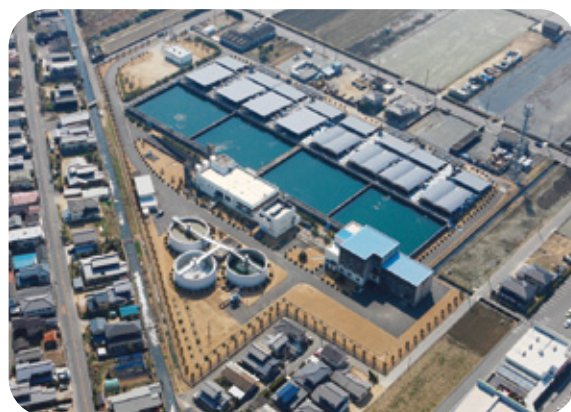
鶴新田浄水場
