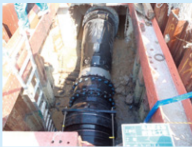
亀島配水池耐震対策
