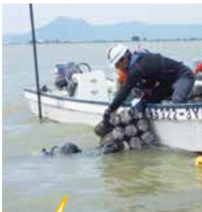
魚礁設置作業の様子
