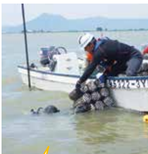
魚礁設置作業の様子
