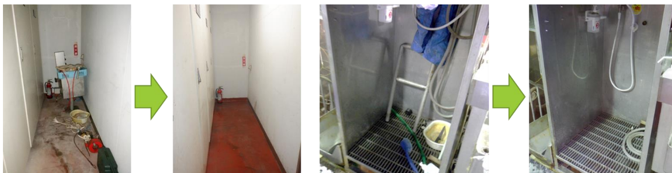
図1：場内の不要物撤去
