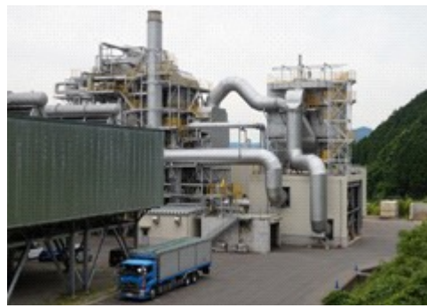
木質バイオマス発電所
