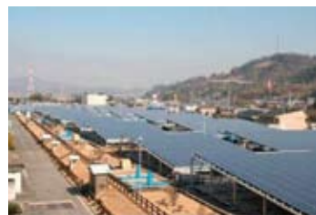
企業局西之浦浄水場
