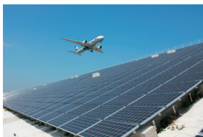
岡山空港太陽光発電所
