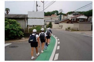
路肩部分のカラー化による即効的な安全対策
