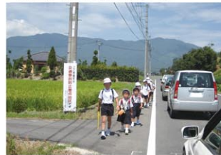
歩道が無く危険な通学路
