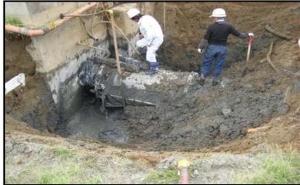
構造物接続部の配管離脱状況(茨城県)
