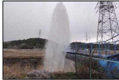
水管橋空気弁からの漏水(福島県)
