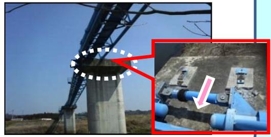
水管橋支承部の破断と横ずれ(宮城県)
