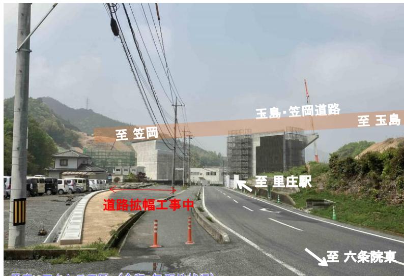
里庄ICアクセス工区 (令和5年 現地状況)
