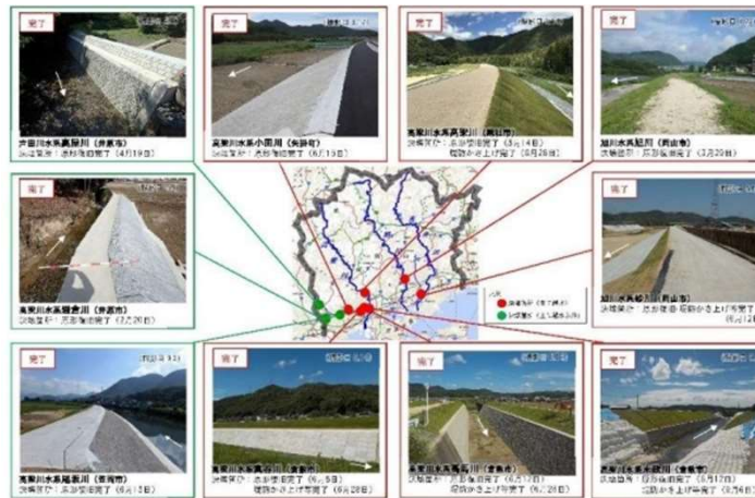
図出典：平成30年7月豪雨で被災した河川の復旧への取り組み（岡山県） ( https://www.pref.okayama.jp/page/621310.html )を加工して作成
