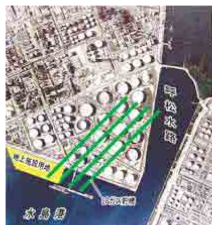
【写真説明】 空から見たLPG備蓄・倉敷基地の建設地 （4本線が地下貯蔵タンク） <山陽新聞社提供>
