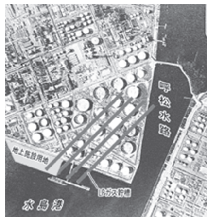
【写真説明】 空から見たLPG備蓄・倉敷基地の建設地 （4本線が地下貯蔵タンク） <山陽新聞社提供>
