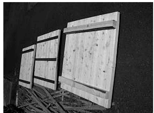
写真2 軽量化したパネル(裏面)
