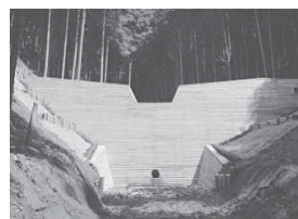
木製残置式型枠による治山ダム (美作市檜原上)
