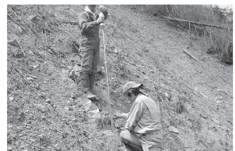
写真2 簡易貫入試験
