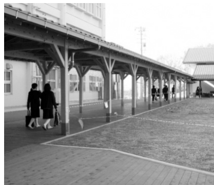
昨年 11 月に完成した早島中学校の渡り廊下とウッドデッキ
