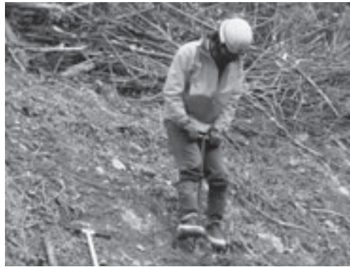
専用機具による穴あけ作業状況
