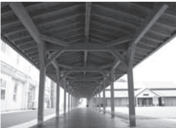
渡り廊下・交流ウッドデッキ
