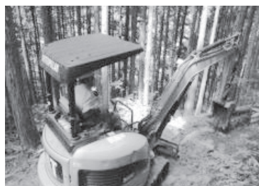
愛用のミニ油圧ショベル (バケット容量 0.09m 3 )
