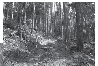
作業道（幅員：1.8m）
