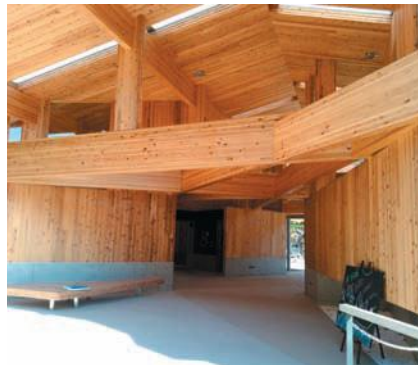
②道の駅「あわくらんど」のトイレ (CLTパネル工法)
