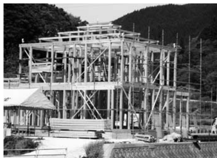
森林認証材で建築中の木造住宅
