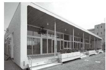
【CLTによる木造建築(保育施設)】
