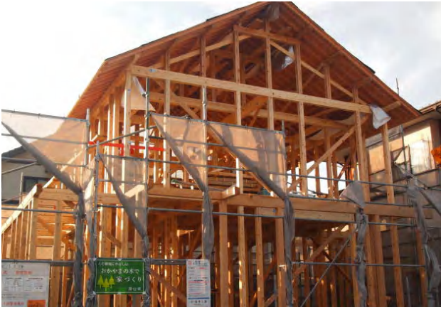
県産材利用住宅
