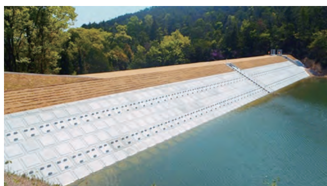
改修後のため池（岡山市）
