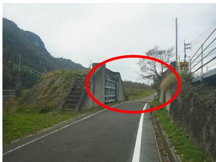
(例) 道路に横断してある陸閘
