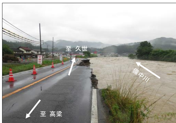
国道313号 (真庭市下方)
