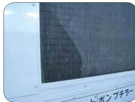
熱交換器の劣化
