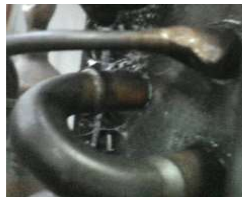
⑫ 蒸発器や凝縮器のUバンド部
