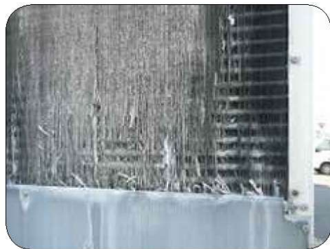
熱交換器の劣化
