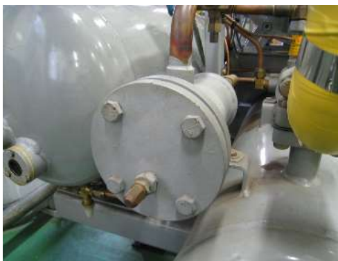
④ 機械式継手とフランジ
