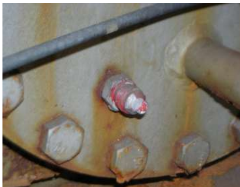
⑤ 溶栓と安全弁 (高圧保護)
