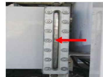
冷媒液面の低下
