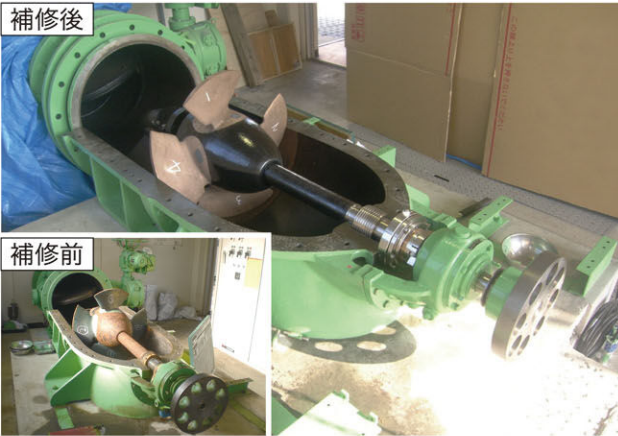
黒石地区（倉敷市）【排水機の分解整備】
