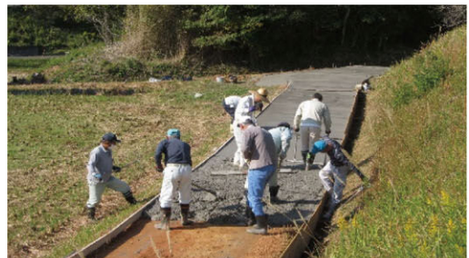
長寿命化 (農道のコンクリート舗装)
