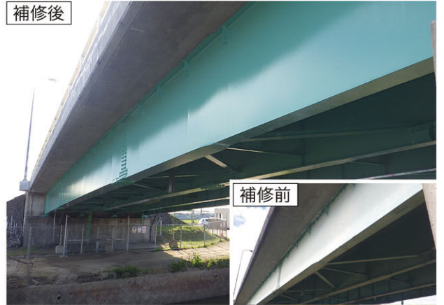
児島湾地区（岡山市）【橋梁の長寿命化対策】
