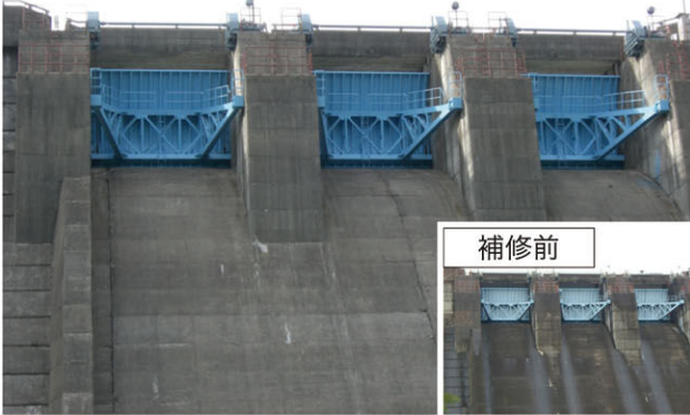
香々美ダム（鏡野町）【ゲートの補修】
